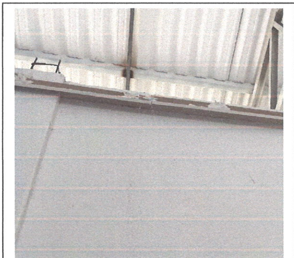
FOTO137: Moldura forro de gesso
