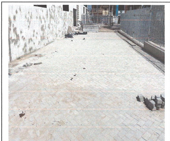
FOTO145: Assentamento piso intertravado
