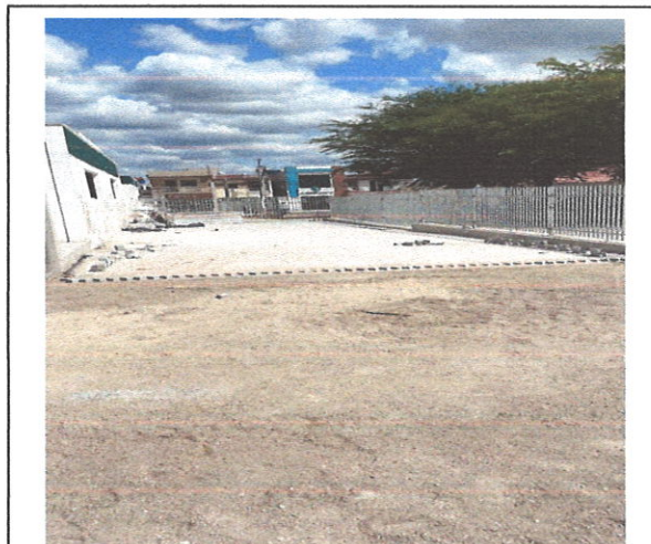
FOTO 146: Aterro e compactação para piso intertravado
