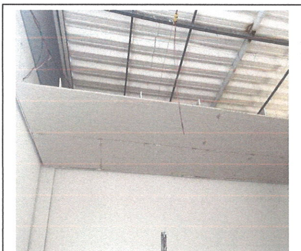
FOTO139: Instalação forro de gesso (Drywal)
