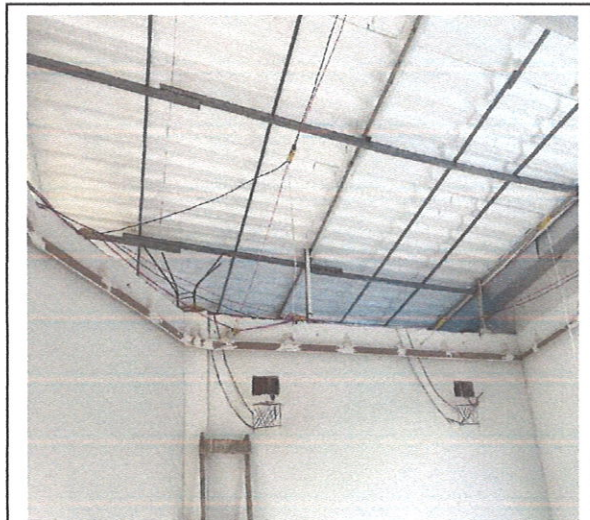
FOTO 138: Moldura forro de gesso
